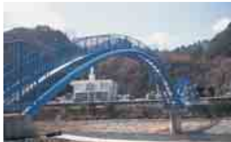
水管橋 Water supply bridges
