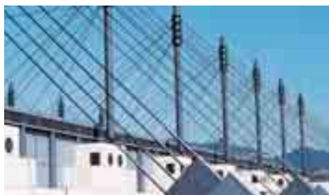
ワイヤーロープ Outer-sheathings of wire ropes for suspension-roofs
