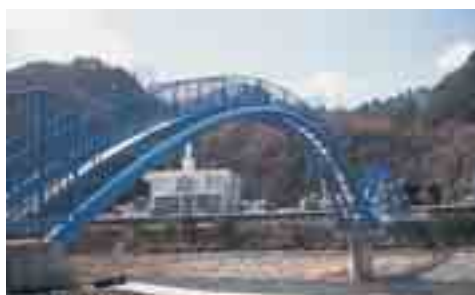
水管橋 Water supply bridges
