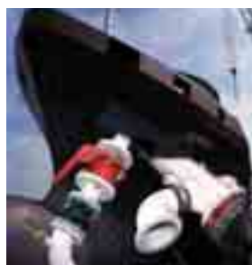
船舶配管 Pipes of ships
